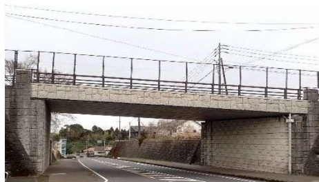
補修工事完成の大原跨道橋
