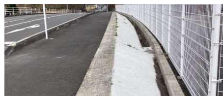
メンテナンスフリー工事实施状況
