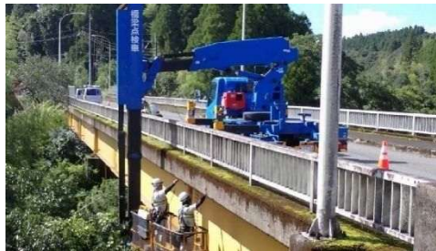
橋りょう定期点検状況
