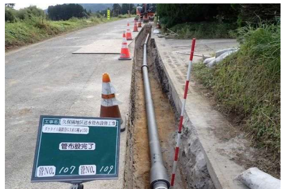
新たに布設した水道管
