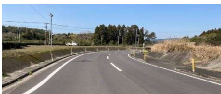
道路整備（舗装）実施状況
