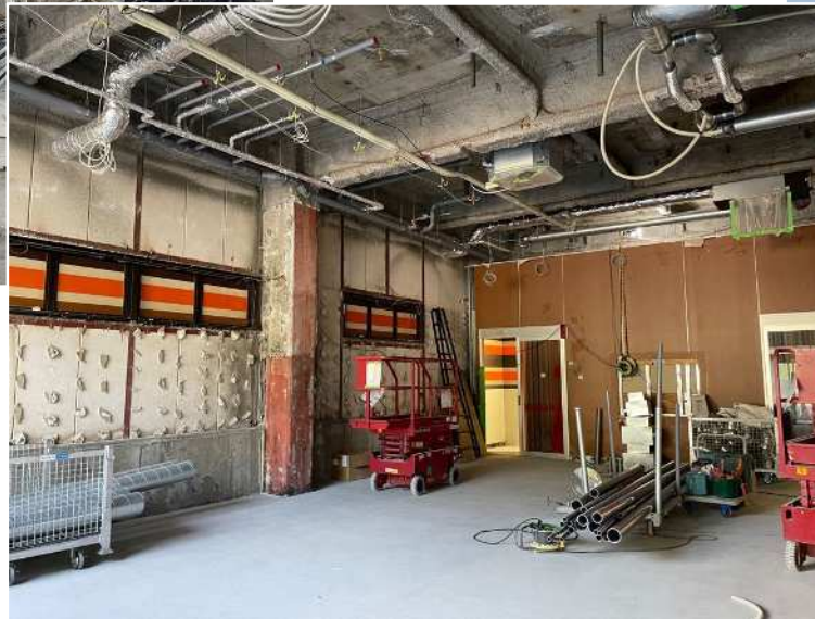
1階の改修状況
