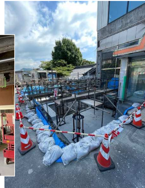
エレベーター棟の新築
